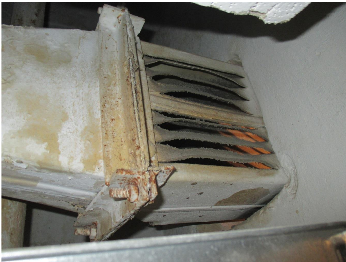
Рис 1.1 – СПК, следы ржавчины, загрязнение воздуховода в санузле на 3этаже.
