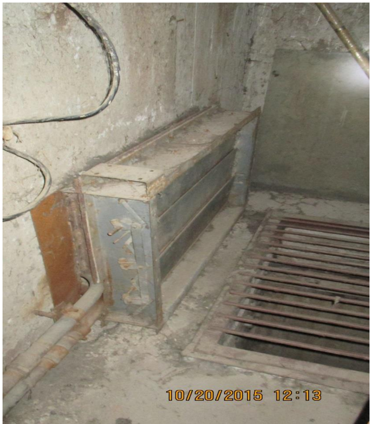
Рис 1.10 – Водоприемник. Оборудование устарело, нет исполнительных механизмов
